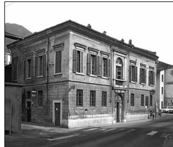
Il Municipio: rimodellato dopo l'intervento Viganò, fu demolito negli anni '80 per l'ampliamento della ex SS 510
